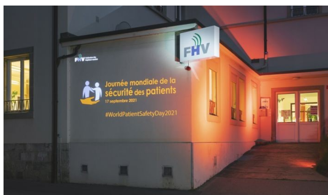
Eclairage de la façade de la FHV, le 17.09.2021
